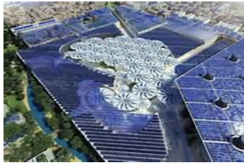
شكل ( 31 ) تصميم المظلات المتحركة التي تفتح نهارا و تغلق ليلا تبعا لضوء الشمس
